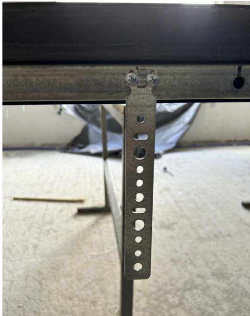
Рисунок 2.3 – Установка анкерных пластин на оконную раму
