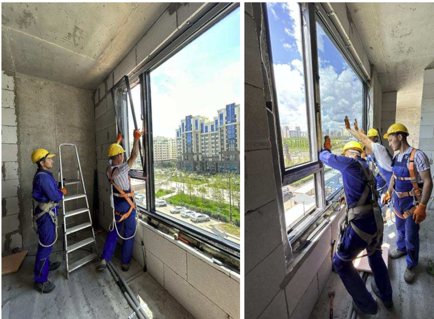
Рисунок 2.8 – Установка стеклопакета
