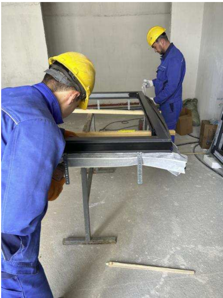
Рисунок 2.3 – Установка анкерных пластин на оконную раму
