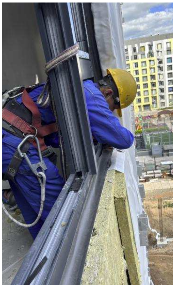
Рисунок 2.7 – Наклейка наружной гидроизоляционной ленты и герметизация шва монтажной пеной
