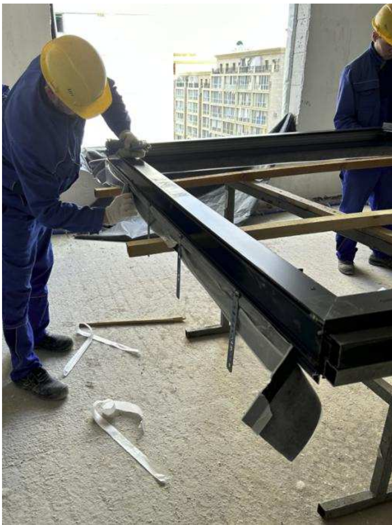
Рисунок 2.3 – Установка анкерных пластин на оконную раму
