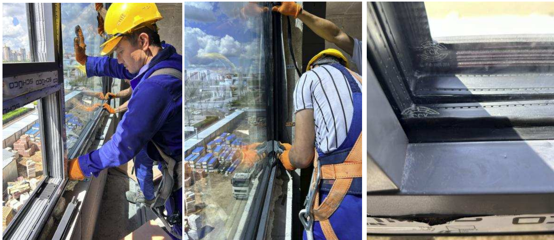
Рисунок 2.9 – Установка штапиков и уплотнительной резины
