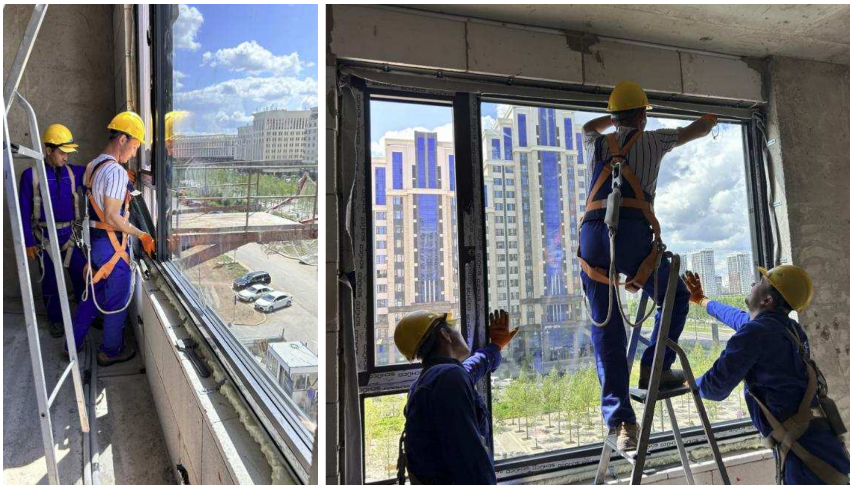
Рисунок 2.8 – Установка стеклопакета
