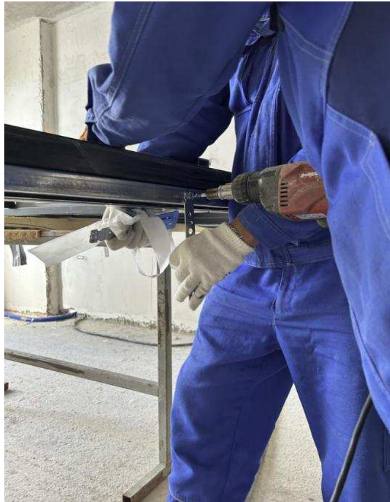
Рисунок 2.3 – Установка анкерных пластин на оконную раму
