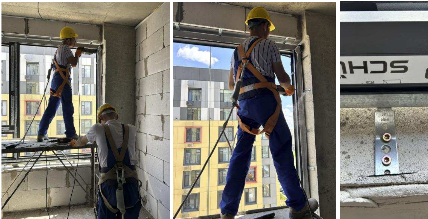
Рисунок 2.6 – Монтаж оконной рамы по бетону
