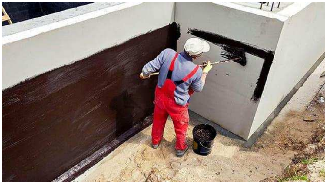
Рисунок 3 – Нанесение битумного праймера
