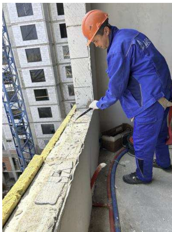
Рисунок 2.5 – Очистка и разметка оконного проема
