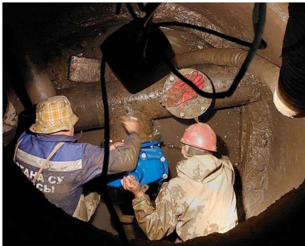
Рисунок 2 - Установка задвижки
