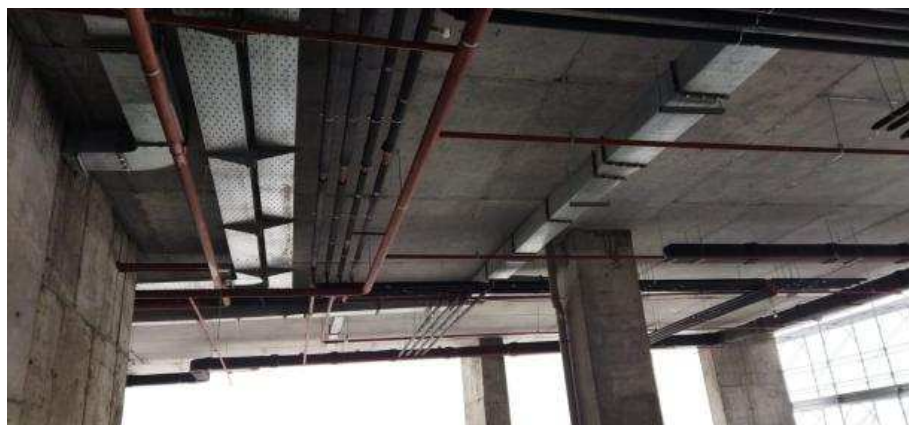
Рисунок 4 – Прокладка стальных трубопроводов
