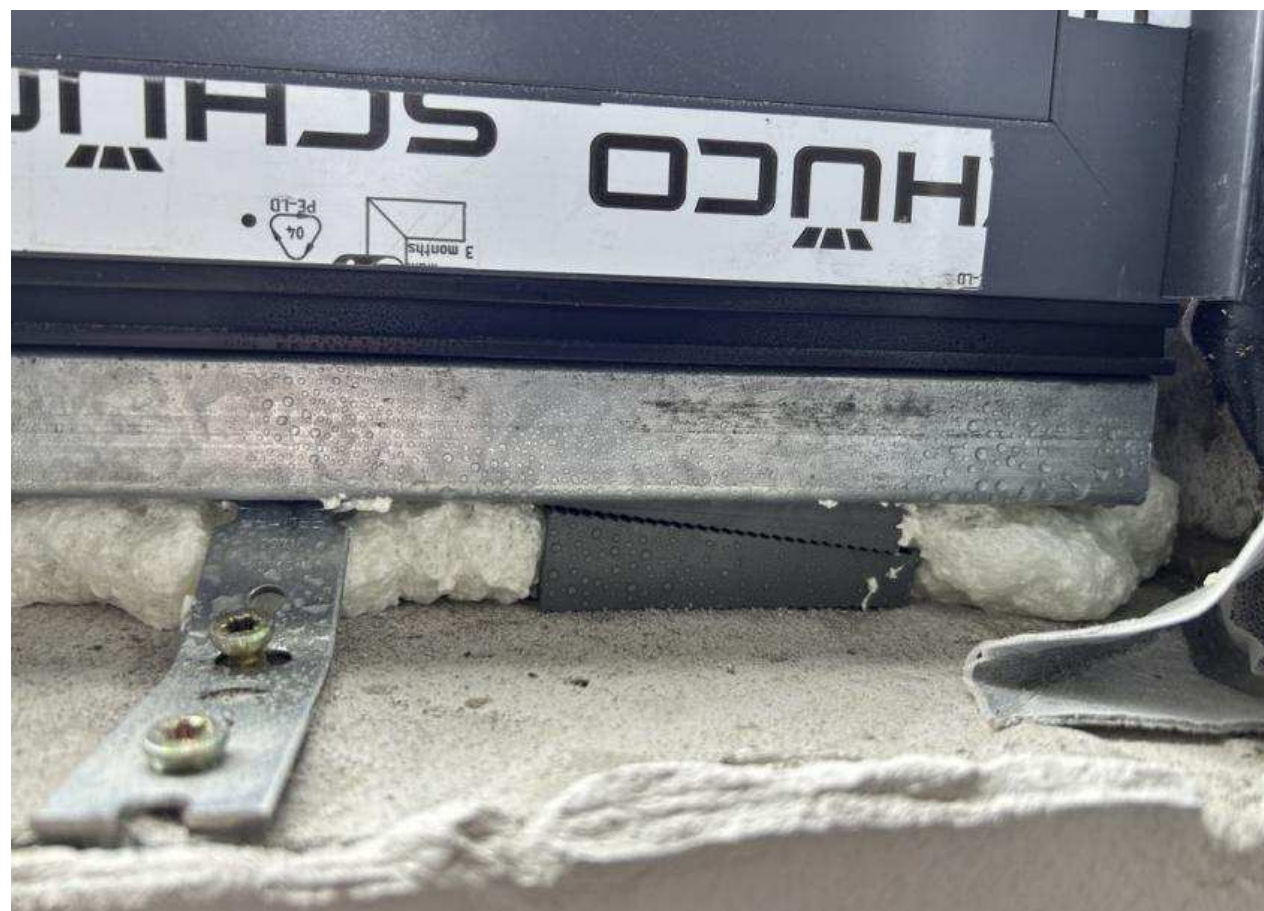
Рисунок 2.7 – Наклейка наружной гидроизоляционной ленты и герметизация шва монтажной пеной
