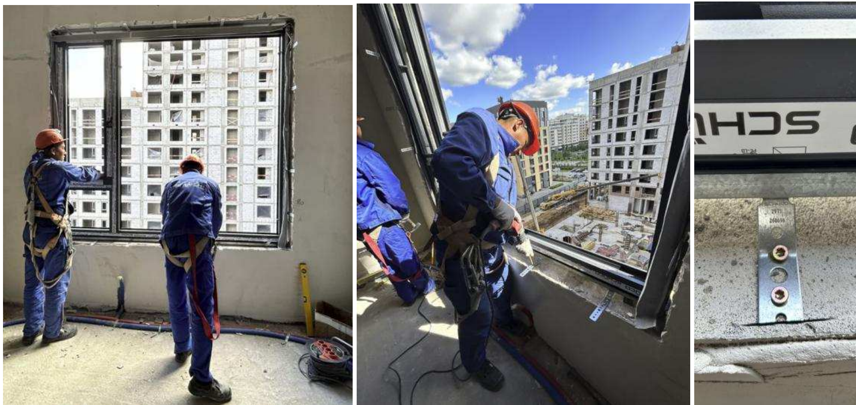
Рисунок 2.6 – Монтаж оконной рамы по газоблоку
