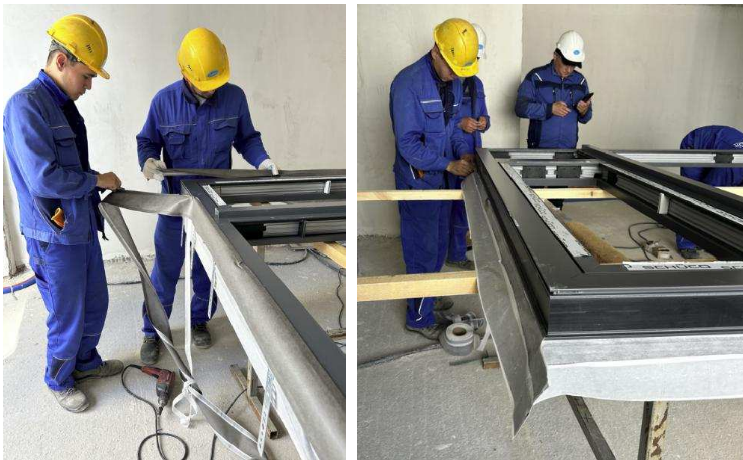
Рисунок 2.2 – Наклейка внутренней и наружной гидро-пароизоляционных лент
