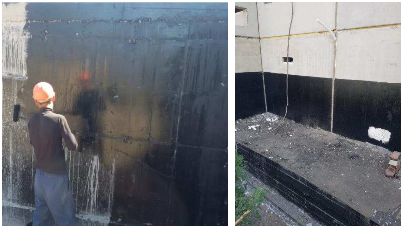
Рисунок 4 – Нанесение гидроизоляционной мастики
