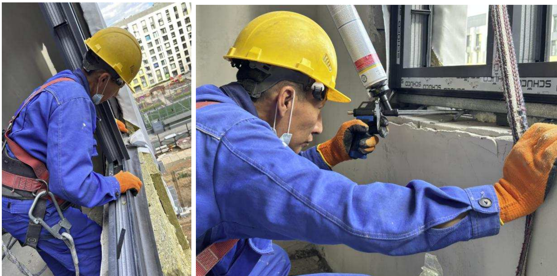
Рисунок 2.7 – Наклейка наружной гидроизоляционной ленты и герметизация шва монтажной пеной
