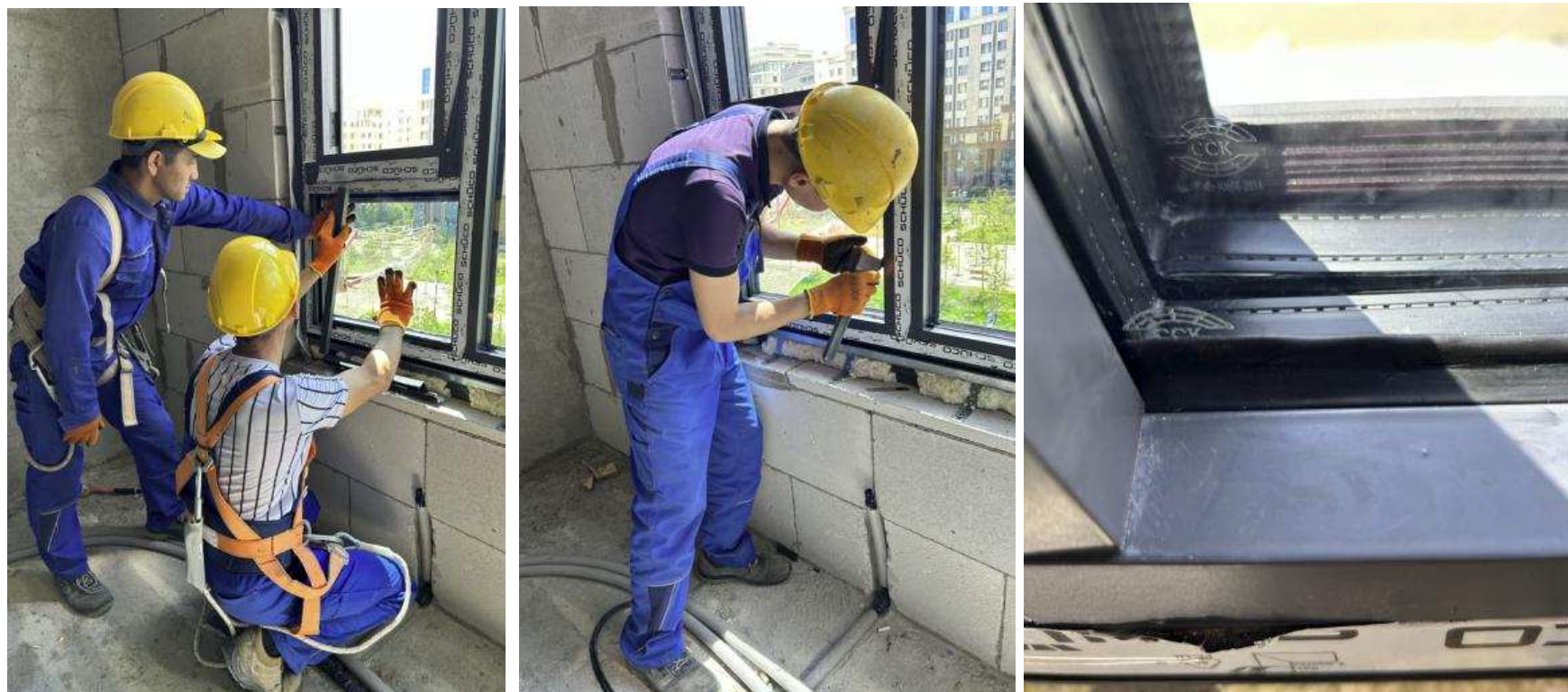
Рисунок 2.9 – Установка штапиков и уплотнительной резины
