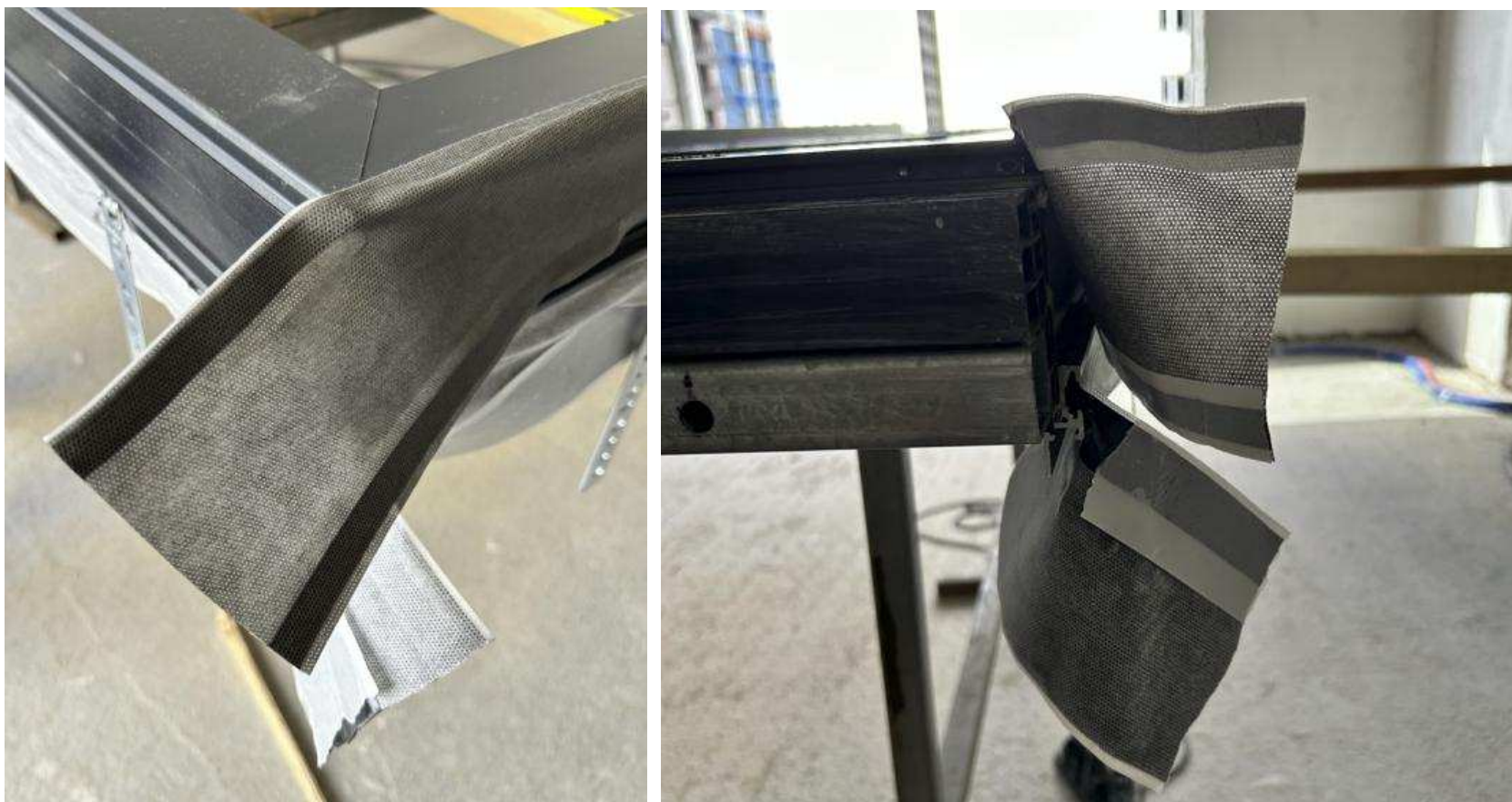
Рисунок 2.2 – Наклейка внутренней и наружной гидро-пароизоляционных лент
